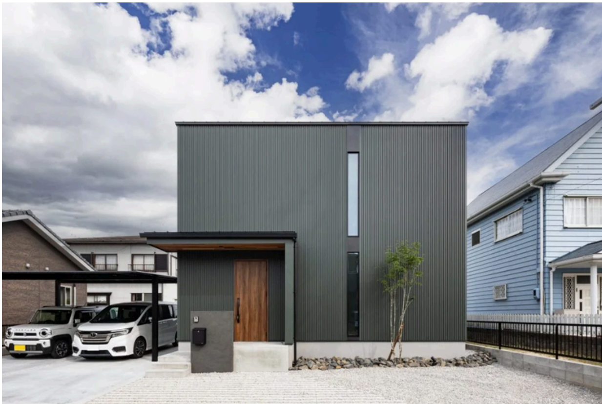
グリーンのガルバリウムにスリットの窓が印象的な外観デザイン
